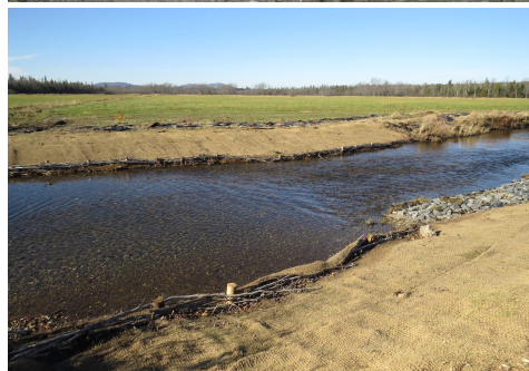
La traverse à gué avant et après les travaux
