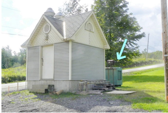
Station de pompage au chemin Centre avec la génératrice (voir la flèche)
