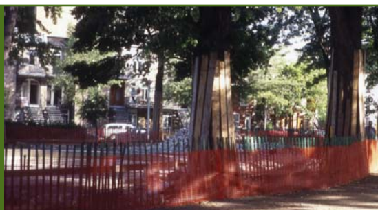
Installation de protecteurs autour des troncs d'arbres.
